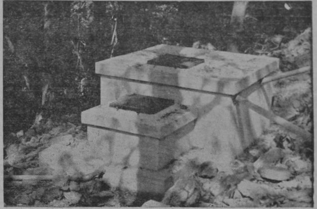
Obras de captación de las fuentes del acueducto de Cañas Dulces de Liberia, completamente selladas, para recoger 1.75 litros de agua por segundo.
